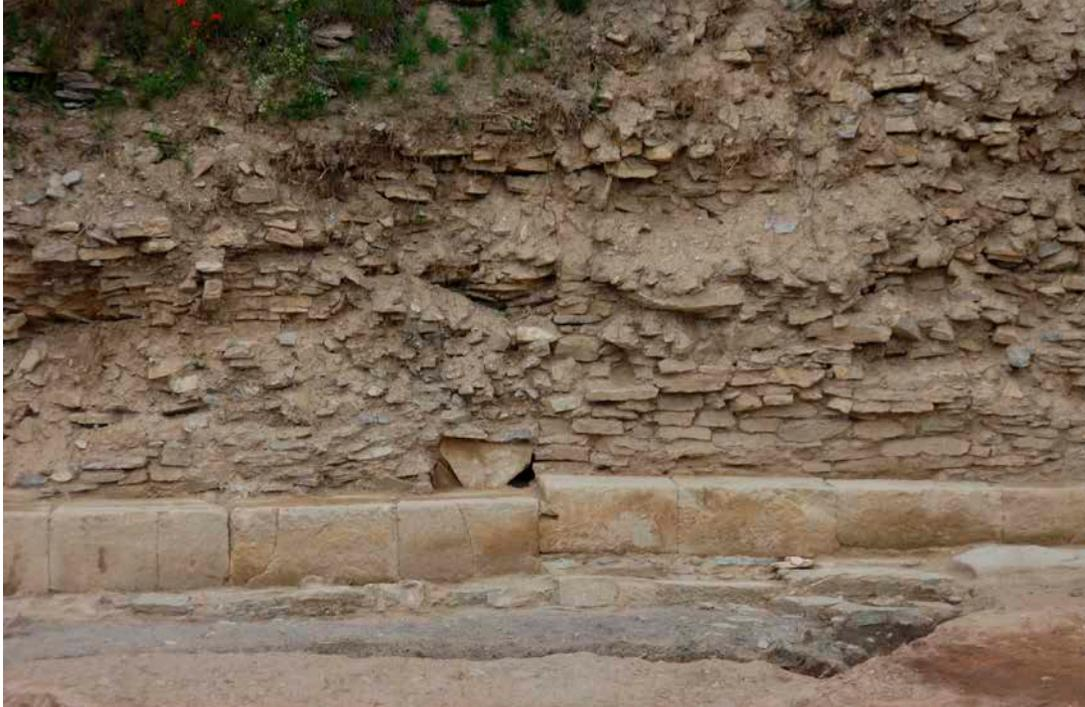
Foto 33. Detalle de la mampostería en la zona central del lienzo E23, donde se aprecia la llaga vertical coincidente con el escalón en la hoja de sillares.
