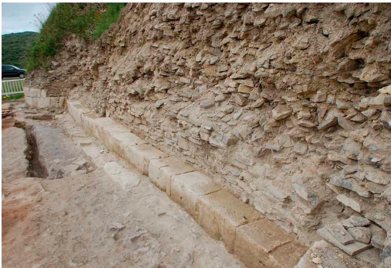
Foto 14. Vista del paramento de sillería, la mampostería irregular del relleno interno y la banqueta de cimentación en el lienzo E23.
